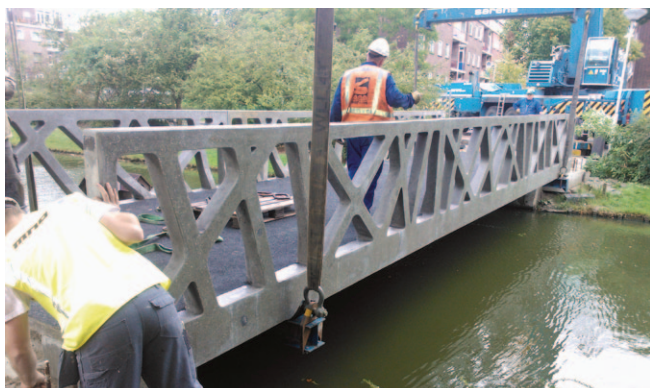
Plaatsing UHSB-brug in Rotterdam
